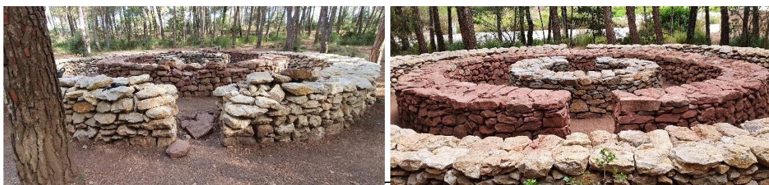
Encerclament d'11,50 m de diàmetre, amb murs de 0,85 m x 0,80 m, construïda amb pedra calcària, llicorella i gres, mitjançant la tècnica tradicional de pedra en sec. El projecte rendeix homenatge a les tradicions culturals del Mediterrani i la geologia local. Comissionat per l'Ajuntament de Begues (VMV, Parc de la Costeta, Begues, 2019).
