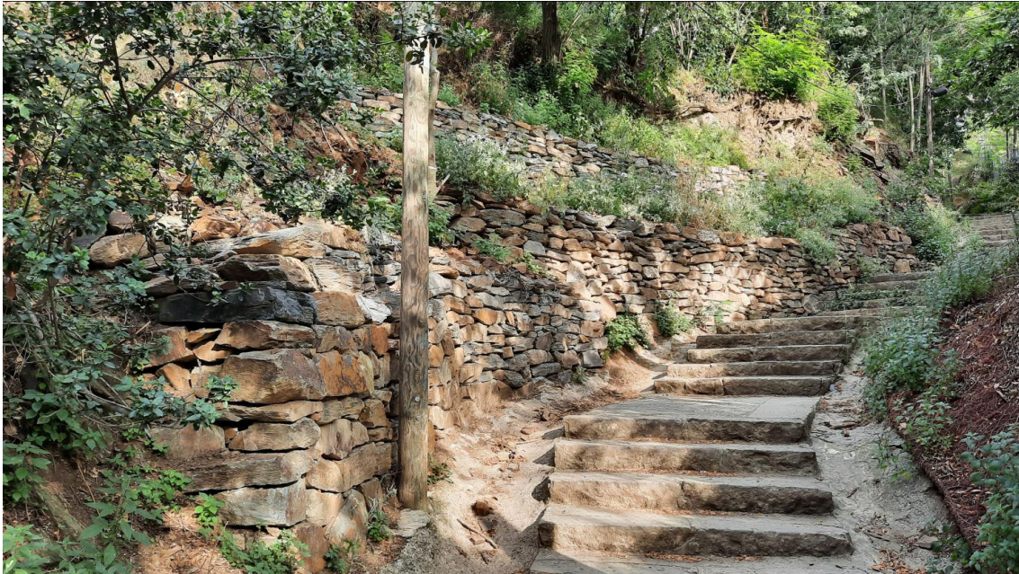
Murets de pedra seca a la Drecera de Vallvidrera (Oficina de Collserola i Roger Soler, 2022)
